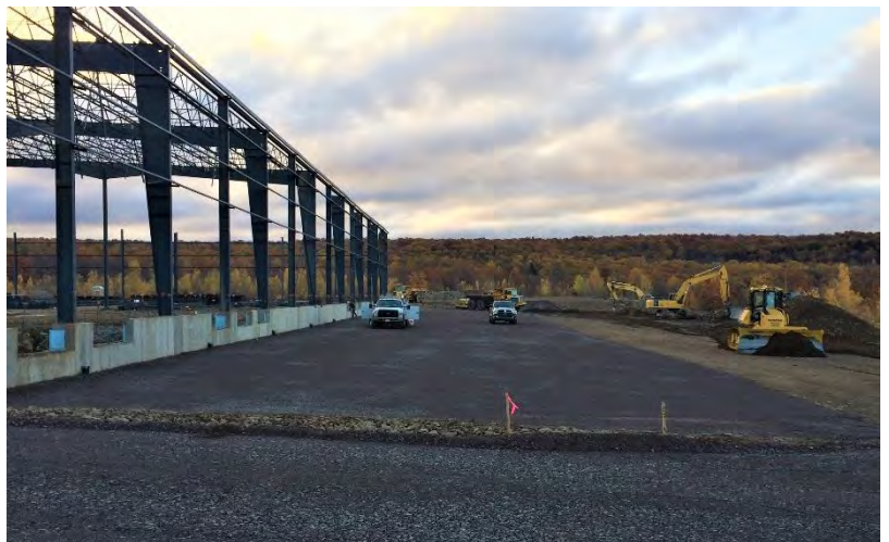
KT Holdings PEMB Construction
